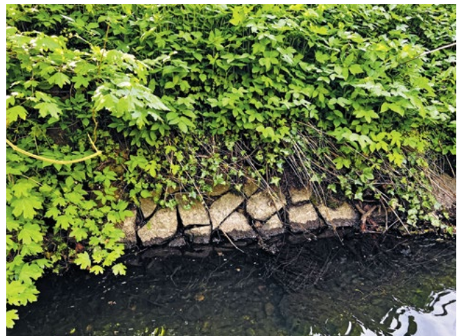
Abbildung 11: Beispiel für Gewässer ausbau und Unterhaltung; linkes Bild: begradigter strukturloser Verlauf der Moorwettern, rechtes Bild: Uferbefestigung durch Pflaster an der Stellau (Fotos: Institut für angewandte Ökologie GmbH)
